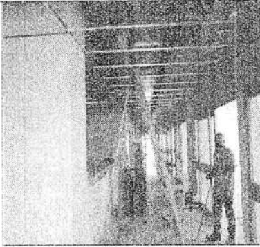
FOTO 13: Instalación de tubería de cobre colgada por losa para la red de gas medicinal en el nivel +20.00m.
