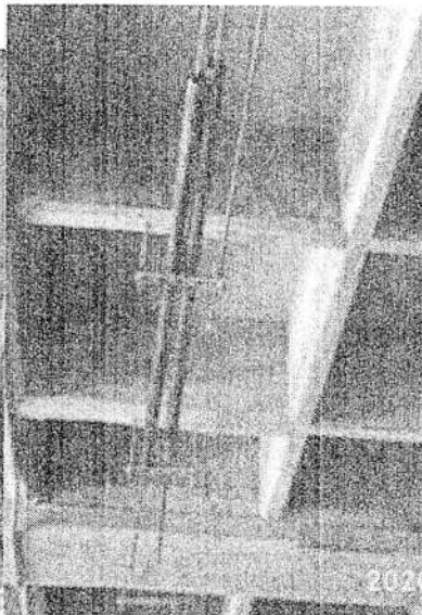
Salida expuesta en caja metálica para iluminación
